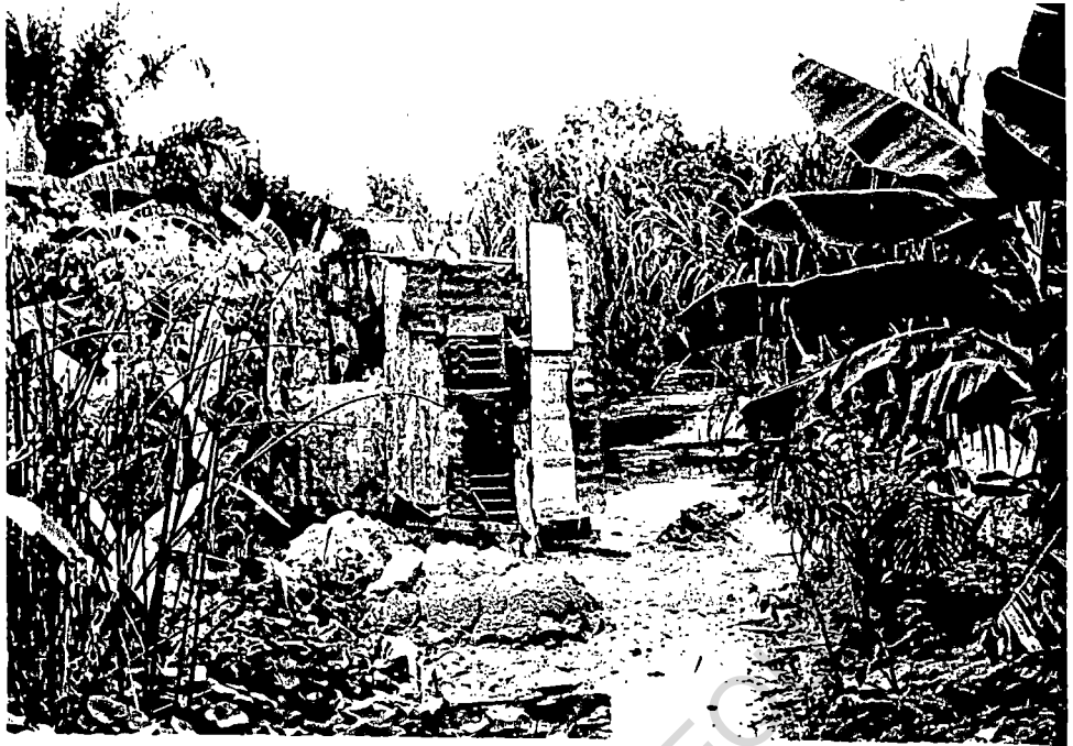
Photo n°10 : Les WC sont généralement érigés sur les bords de la Tsiémé...
