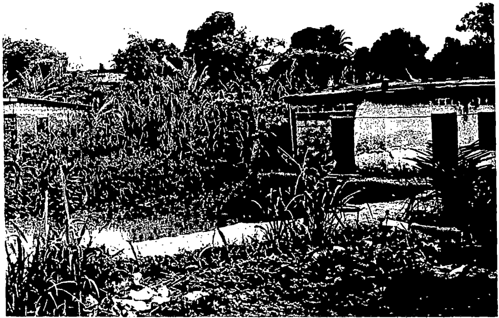
Photo N°20 : Cette maison a été abandonnée à cause de l'humidité, ...
