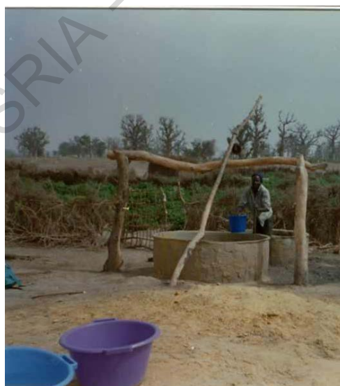
Photo 13 : Puits avec margelle équipé d'une poulie pour exhaure (Kër Balla Ngom, Thiénaba)
