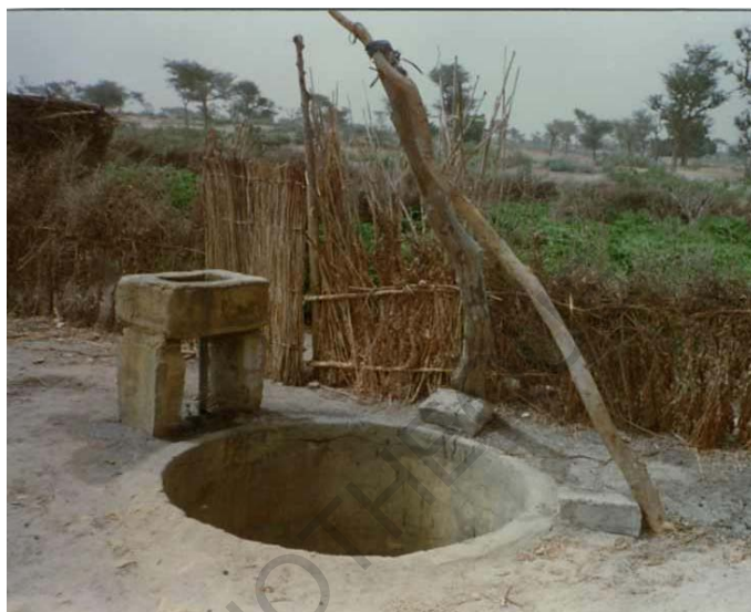
Photo 12 : Puits cimenté sans margelle équipé d'un bassin alimentation pour les exploitations
