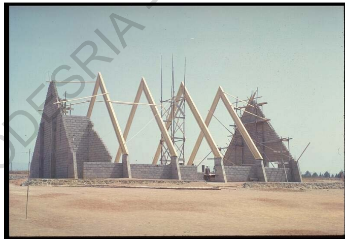
Photo 29: Construction de l'église Béthanie (derrière le stade Ndoumbé Oumar) à Ngaoundéré ; Année : 1963
