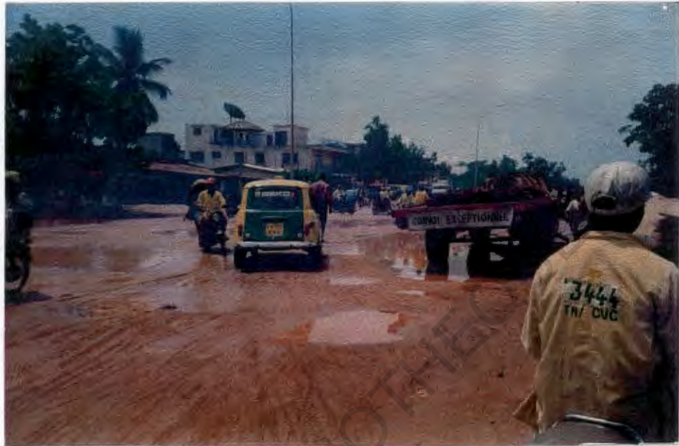
Photo N° 1: "Voie 40" étoile rouge-Cadjehoun, en terre difficile à pratiquer, les stagnations d'eau contribuent à sa détérioration. Remarquez l'anarchie qui caractérise la circulation.
