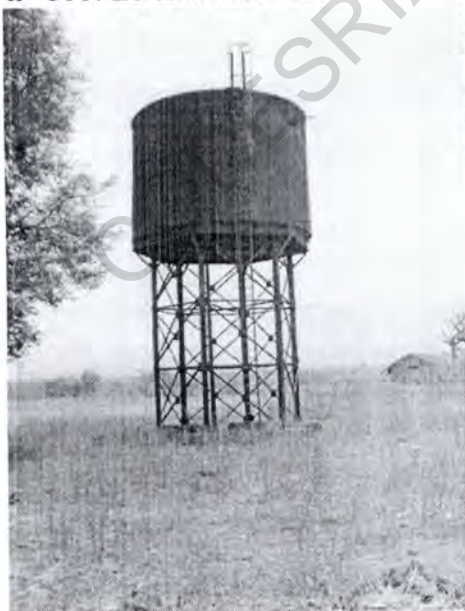
Photo n° 100: Le château d'eau.
