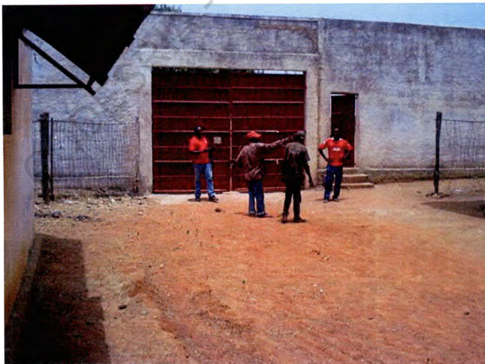
Photo n° 79 : barrière vue de l'intérieur
