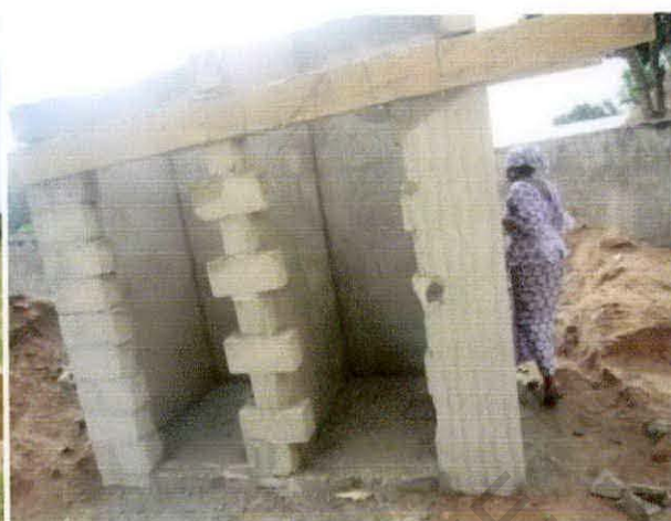
photo de latrines en construction
