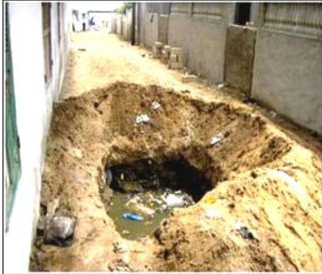
Figure 4 : Trou des eaux vannes déversées dans la rue
