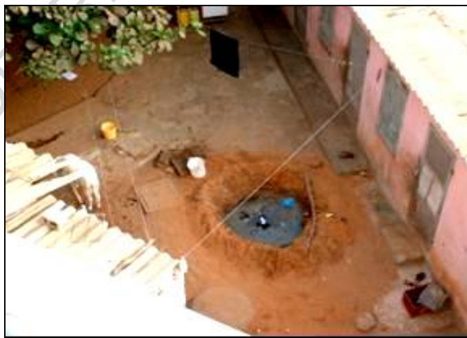
Figure 5 : Trou des eaux vannes dans la cour de la maison
