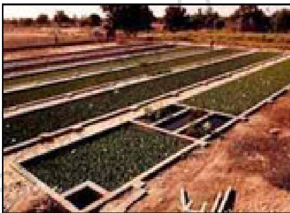
Figure 13: photo de centre de lagunage à Diokoul
