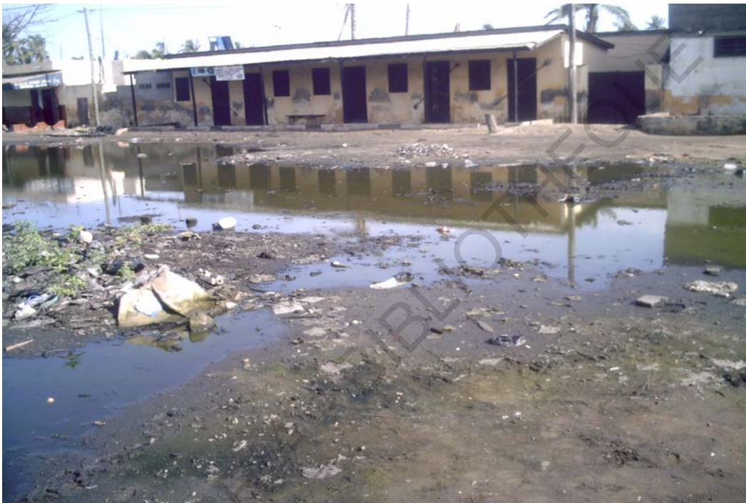
Photo n° 4 : Une maison inondée dans le quartier de Baguida
