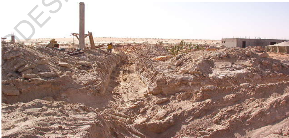
Centre d'enfouissement Technique (CET) en cours de construction
