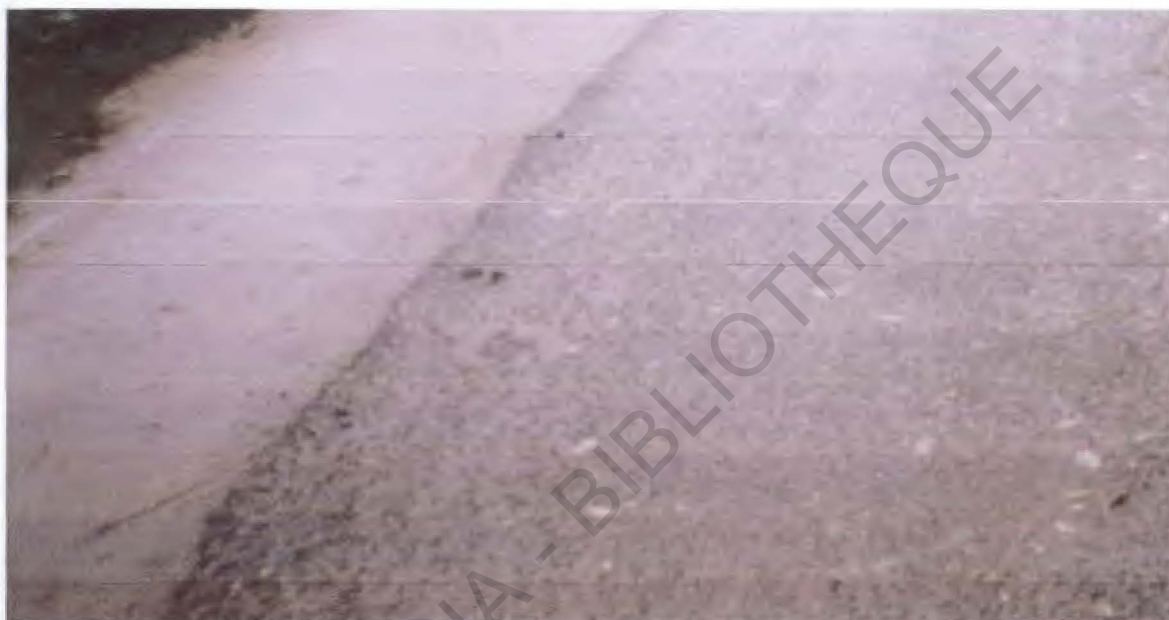
Photo n°28 : L'état d'ablation de la moitié gauche de la chaussée de la route reliant Kessibo-Wawa et Abrewanko dans le Litimé
