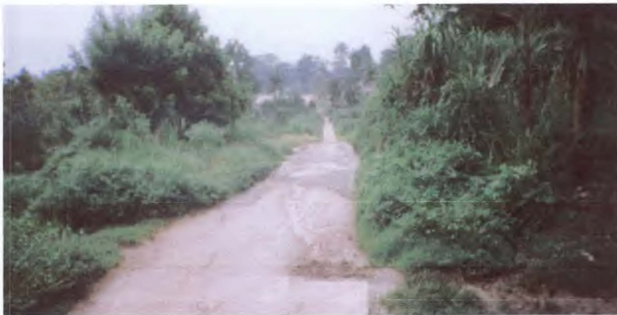
Photo n°29 : Une route anciennement asphaltée, aujourd'hui réduite à une piste : le tronçon Ananikopé à Badou-Dzindzi dans le Litimé
