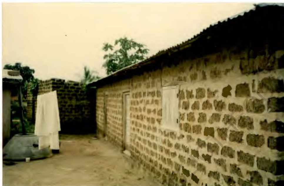
⑭ LOGEMENT EN ADOBES COLLES AVEC DU CIMENT (TYPE DE SEMI-DUR)
