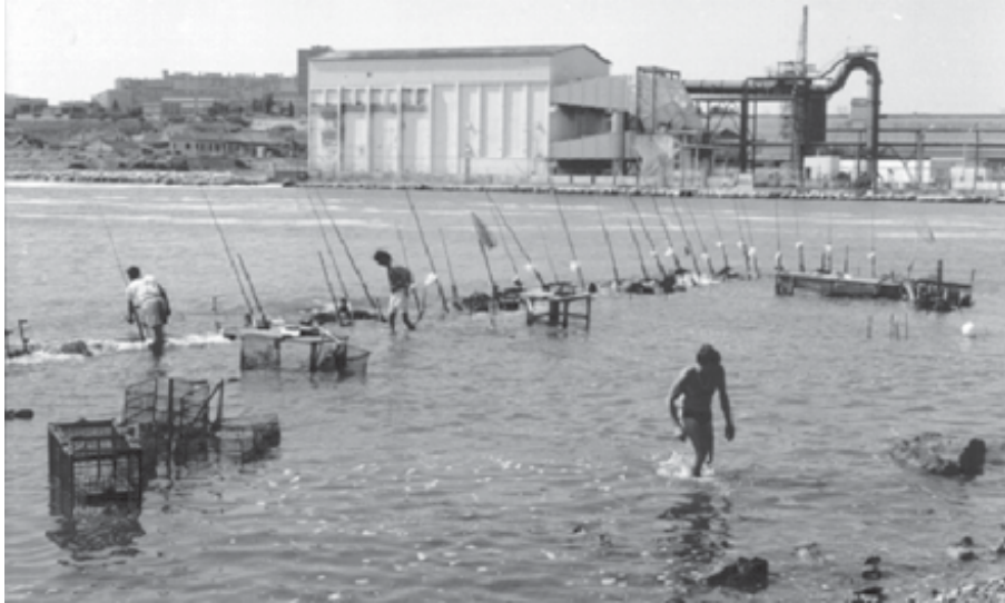
13. Caronte Canal (Martigues, July 1996). Photograph: Franck Pourcel.
