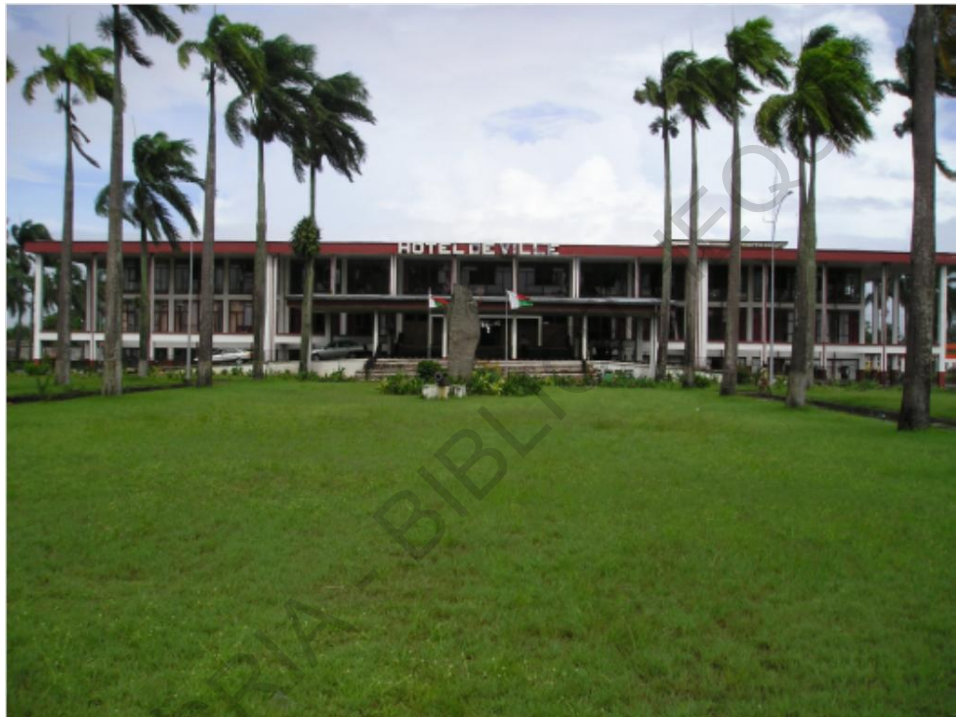
Photo 1 : L'Hôtel de ville de Toamasina, vue depuis l'avenue de l'Indépendance.
