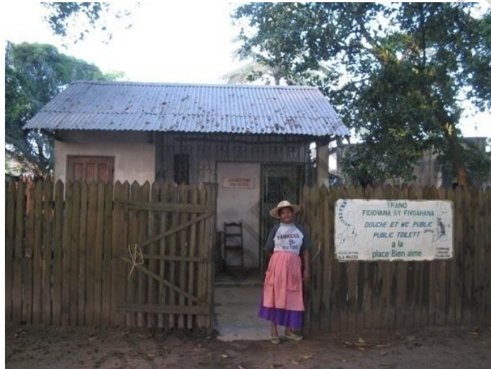
Photo 18: Bloc douche WC à Ampasimazava (avril 2007)
