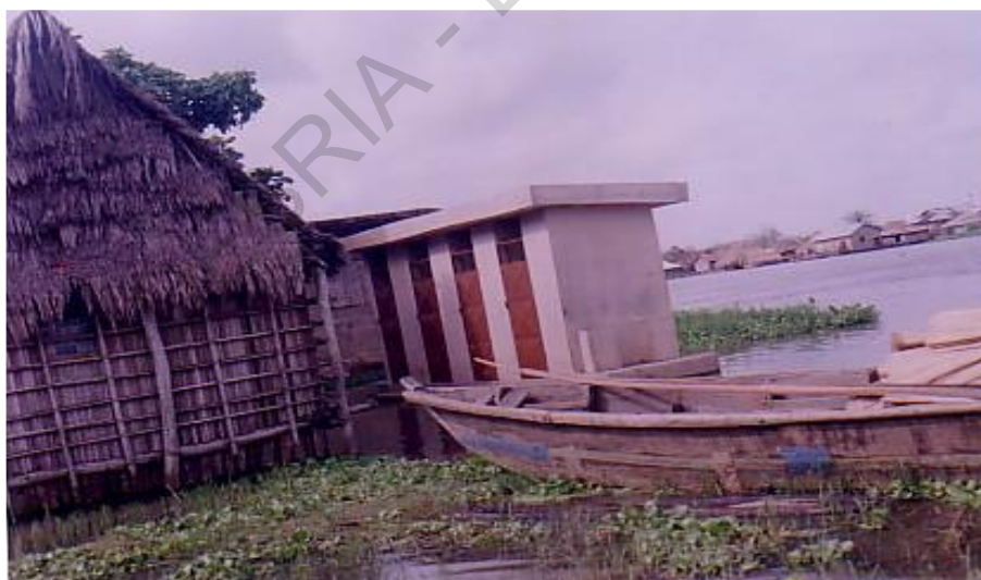
Photo 21 : Latrine publique mal positionnée à Akpadon
