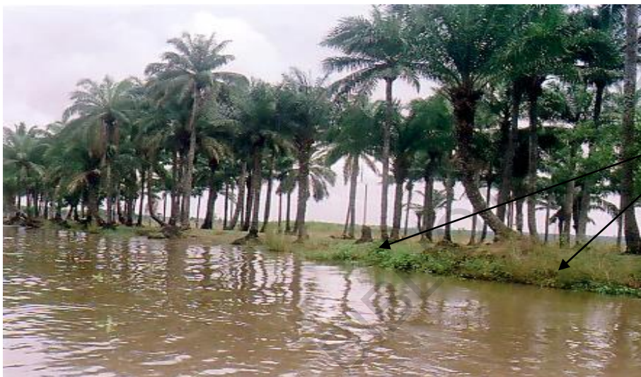
Photo 37 : Erosion de la berge : côté Est au niveau de la cocoteraie Prise de vue : Allognon, août 2012
