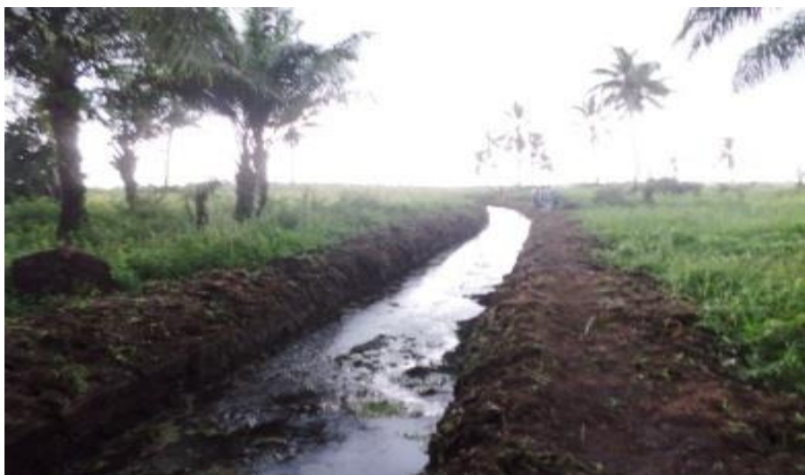
Photo 2 : Drainage d'eau et de limons à Akpadon
