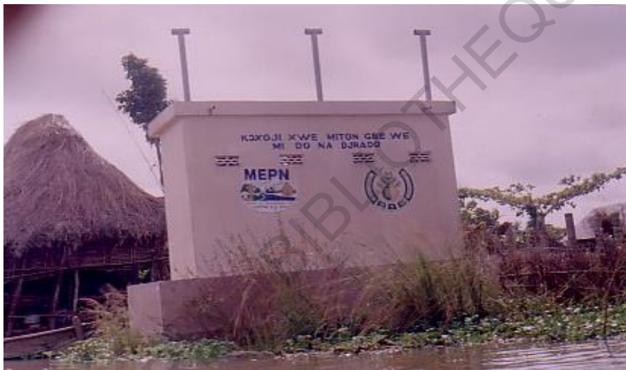
Photo 29 :Latrine publique construite à Gbodjè Prise de vue : Allognon, mars 2012
